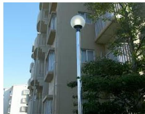
▶LEDに比べて熱と湿気に強い無電極ランプですが、360度光が広がるため上方に灯りが漏れます。リフレクター付きの専用灯具なら下方向に灯りを集中することが可能です。
