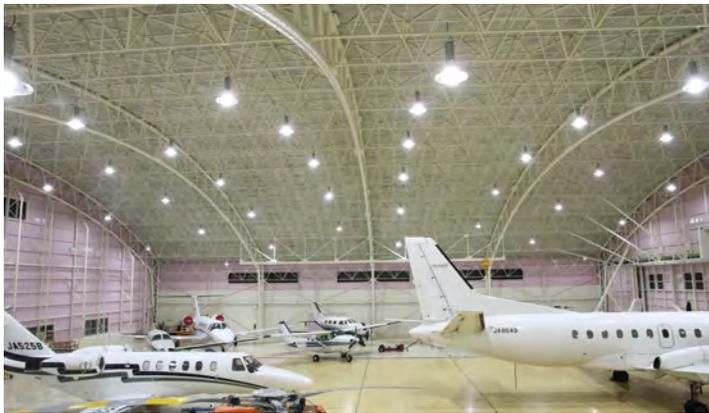
無電極ランプ昇R2が昇R2Nとしてリニューアル。高効率反射板を採用することにより、照度が大幅にアップしました。また、ポリカーボネイトカバーを標準装備。反射板の汚れを防ぎ、高い反射率を保ち続けると同時に、災害などによる万が一のガラス飛散も防止します。さらにランプが灯具一体型になったことで放熱効果が高まり、工事も簡単になりました。
